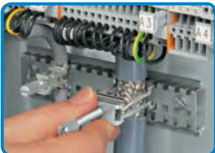
Добавление экранирующей зажимной скобы.
