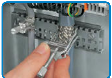
Затягивание/ослабление экранирующей зажимной скобы. Для установки зажимной скобы зажмите винт с рифленой головкой. Для снятия отвинтите винт настолько, чтобы разблокировался храповый механизм, после чего слегка наклоните зажимную скобу и затем снимите ее.
