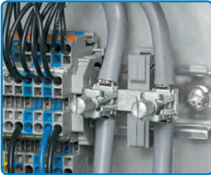
- Держатель с заземляющей ножкой, шинопровод параллельно рельсу
